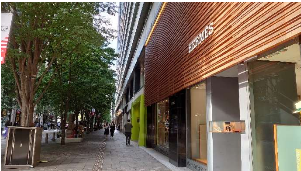
新東京ビル外観
