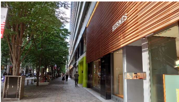
新東京ビル外観
